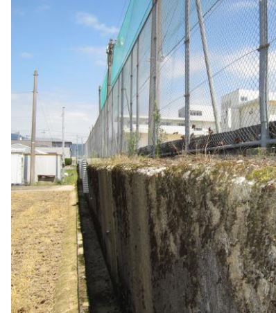
グラウンドの西側擁壁
