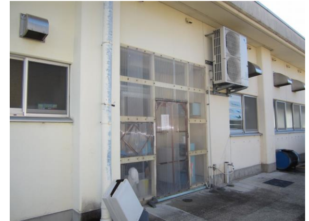
給食室搬入口
