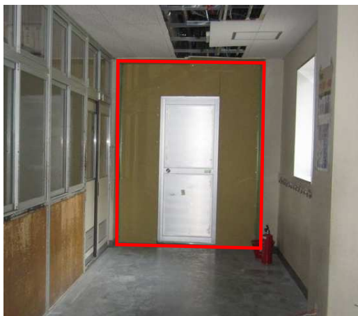
内部仮間仕切 廊下に、改修範囲を区分する間仕切壁を設置
