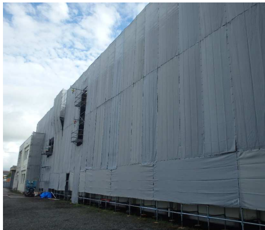
仮設工事（外部足場の設置）
