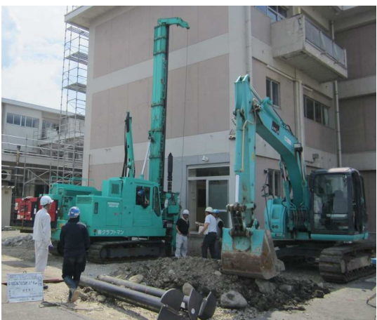
エレベーター増築工事 (鋼管杭打設完了)
