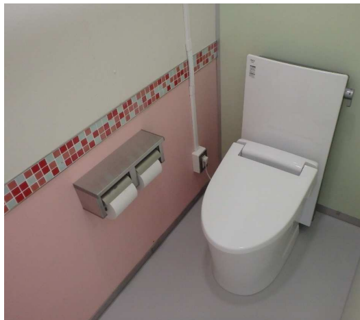
北校舎トイレ洋式化完成
