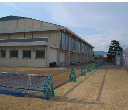
仮設工事（外部通路の設置）
