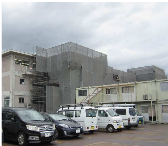
仮設工事 (現場事務所・外部足場の設置)
