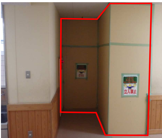
内部仮間仕切
