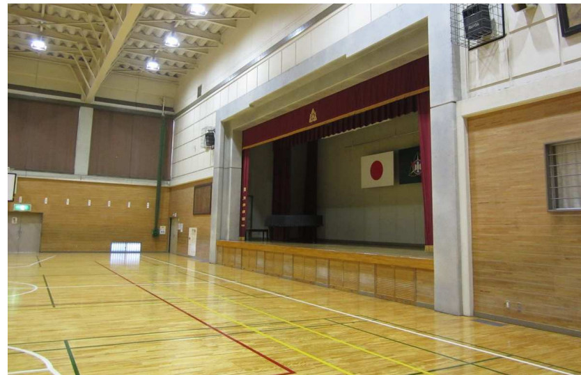
床研磨後、塗装改修 ライン引き
