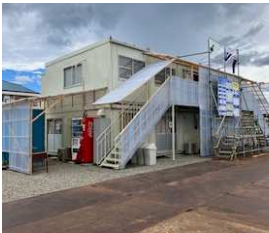
仮設工事（現場事務所の設置）
