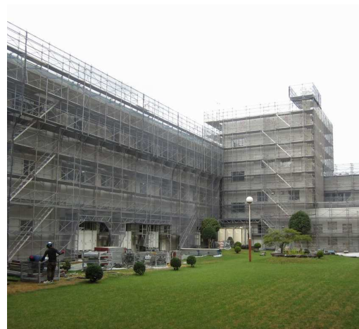
仮設工事（外部足場の設置）
