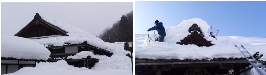
冬期間の施設周囲の積雪状況と屋根雪降ろしの様子
