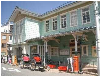
平成大野屋本店洋館
