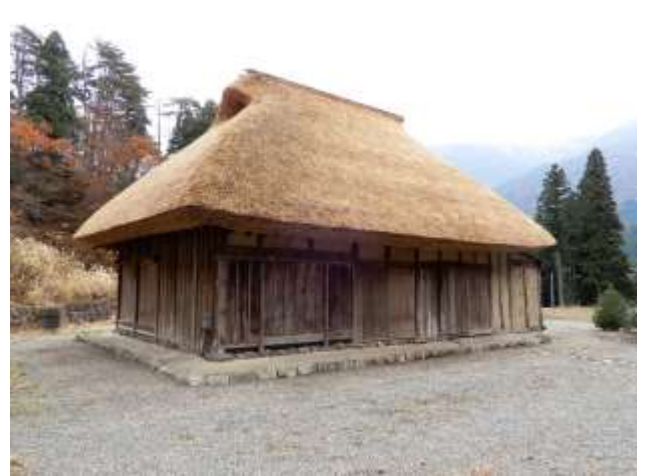
重要文化財「旧橋本家住宅」
