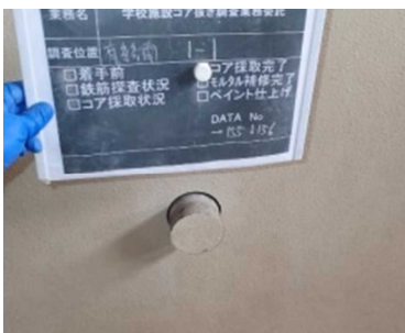
【コアの抜き取り状況】
