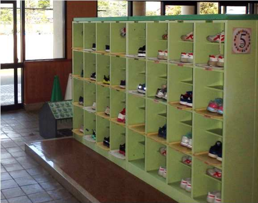
児童玄関 ・経年劣化は少ないが 長靴が入らない下足入
