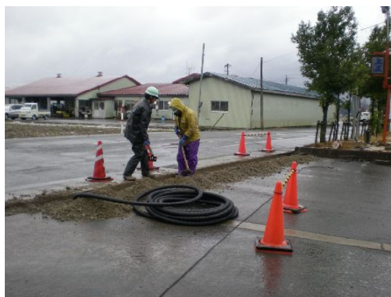
写真5 電源線の埋設工事
