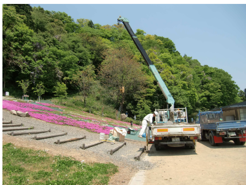
亀山東側緩斜面の整備
