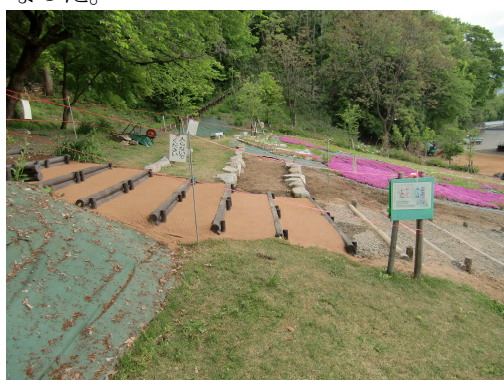
整備された階段
