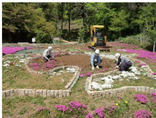
亀山東側緩斜面の整備
