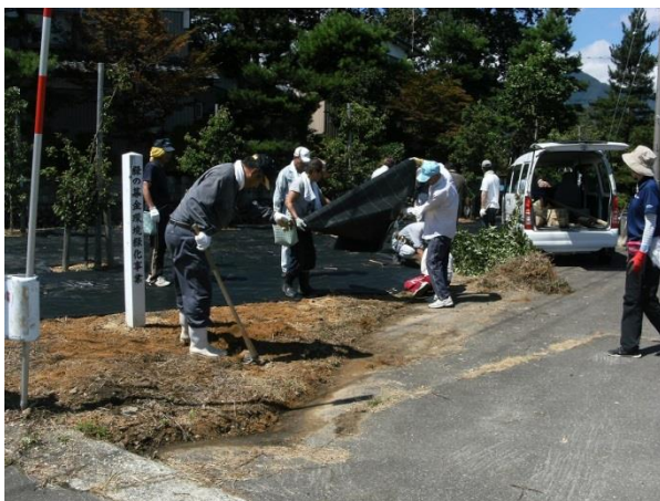
公園での防草シート張り
