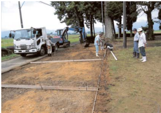
重機を借り上げすき取り作業
