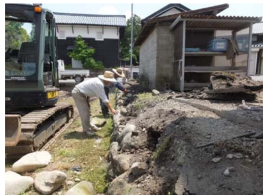
補修作業の様子
