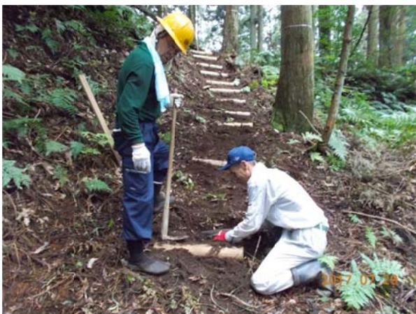
丸太製の階段を設置
