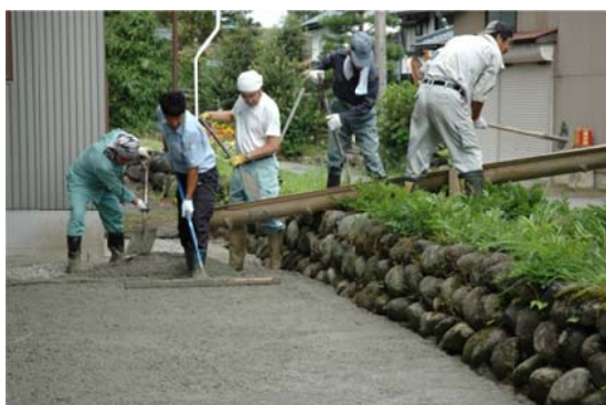
コンクリート打設作業
