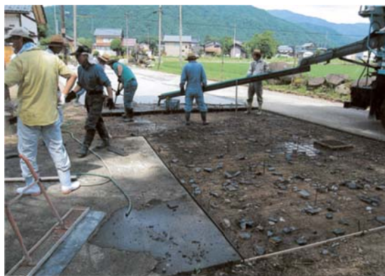
コンクリート打設作業
