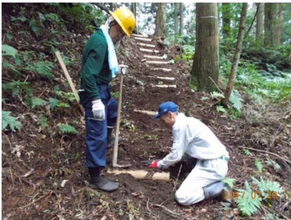
丸太製の階段を設置
