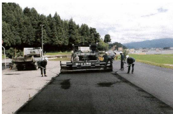
〈駐車場整備の様子〉
