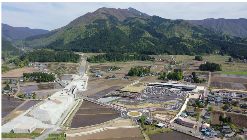
建設中の荒島 I C
