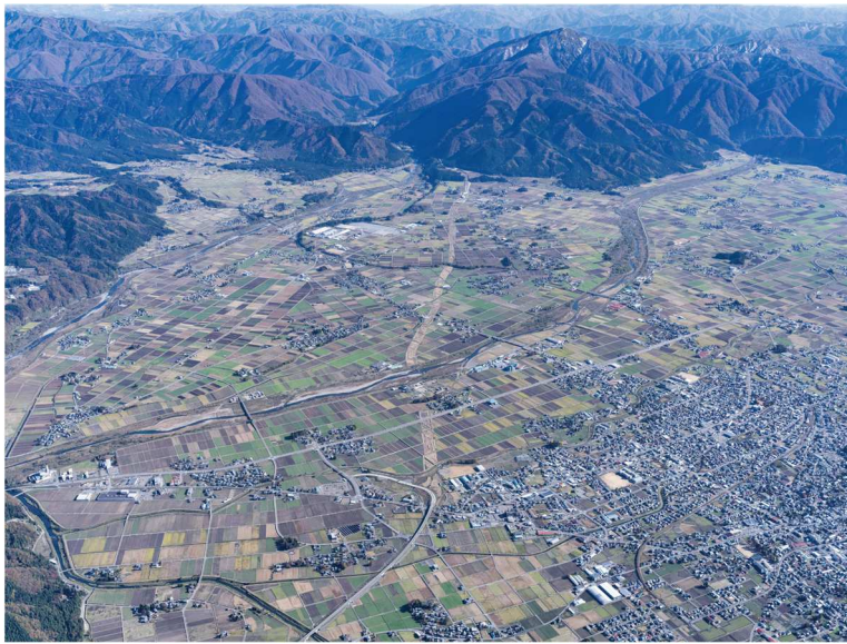
整備中の中部縦貫自動車道（大野ICから荒島IC方面を望む）
