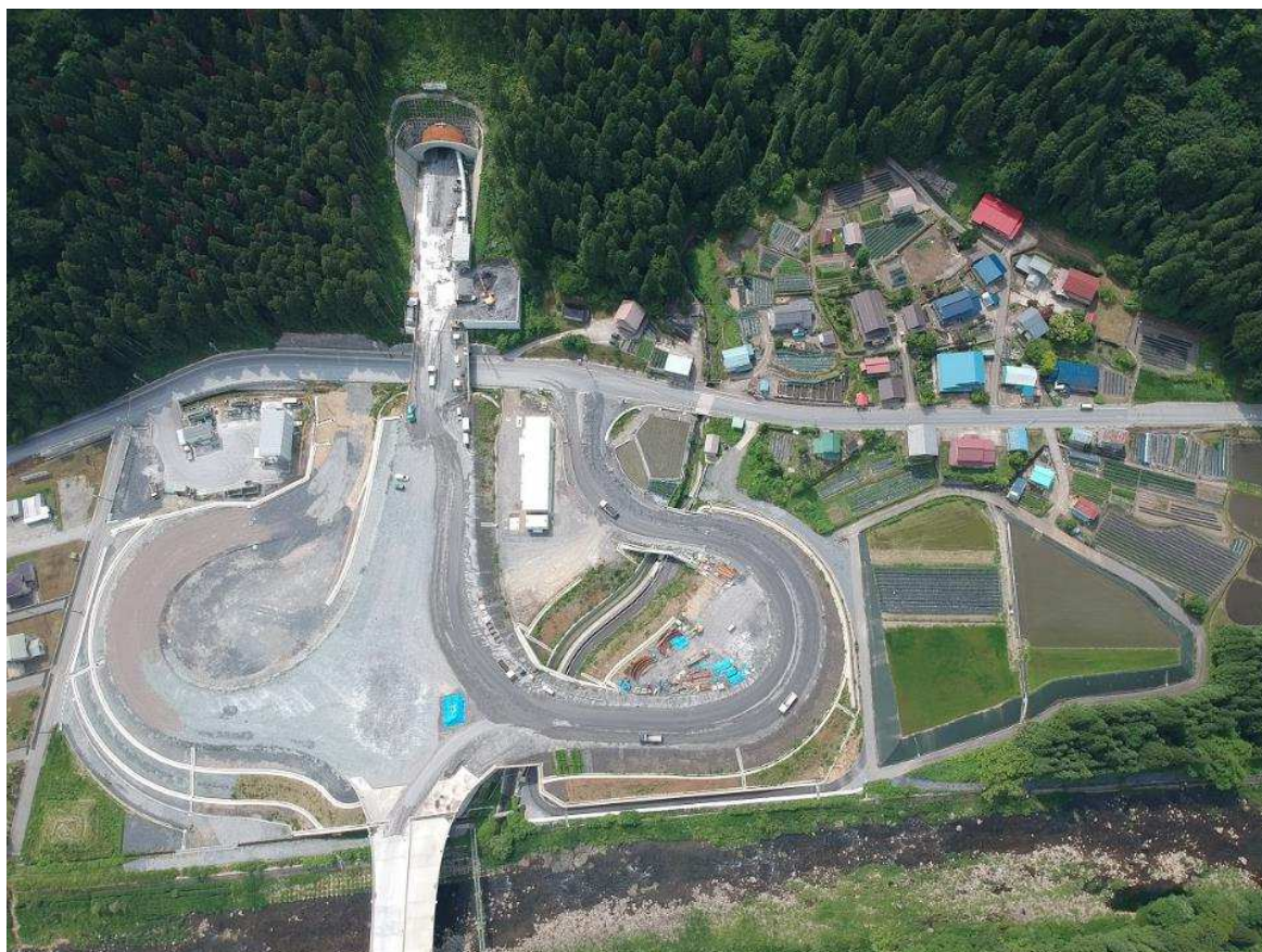
建設中の九頭竜IC
