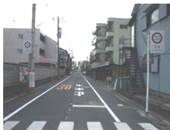
対策後（中央線を抹消し路側帯を設置、背板付き区域規制標識を設置）
