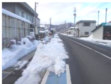
■自転車専用通行帯(自転車レーン)の堆雪帯としての活用
