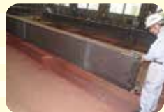
5 製品検査 工作図通りに組立、溶接されているか検査します。
