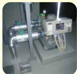
機械器具設置工事
