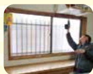
既存サッシの内側に内窓の枠を取り付けます。
