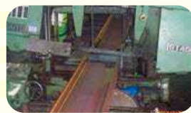
3. 切断 鋼材を専用マシンで切断します。
