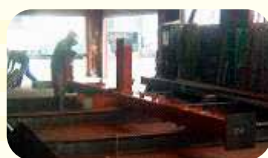
6. 塗装 錆止め用の塗料を塗装して完成です。
