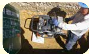
埋設した後、道路に戻すため、埋戻しをします。
