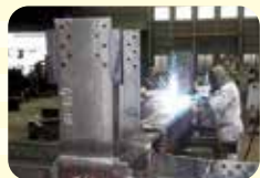
4 溶接 組立後、溶接します。
