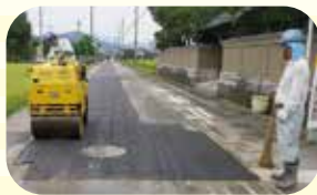
舗装ができ、下水管理設工事は完了です。
