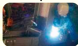
4. 溶接 組立てた部材を本溶接します。
