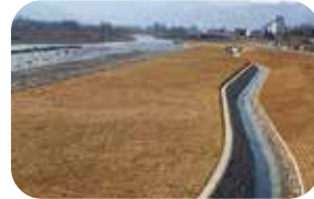
社会資本整備総合交付金事業 (真名川その5)(公園工事)
