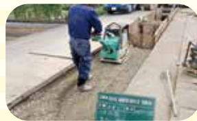
埋戻し後、砂利を敷き、舗装の準備をします。
