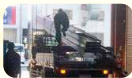
1. 材料搬入 大型トラックで鋼材を納入します。
