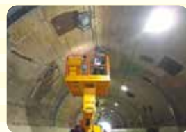
トンネル照明工事
