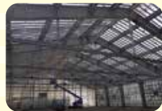
6 建て方 建設現場へ運び、設置します。
