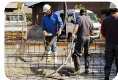
作業現場風景
