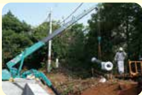
モノレールで資材搬入
