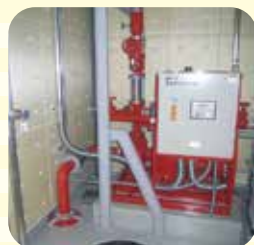
消火設備工事
