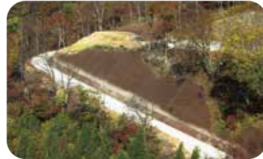
道整備交付金開設工事 奥越線4工区(林道工事)
