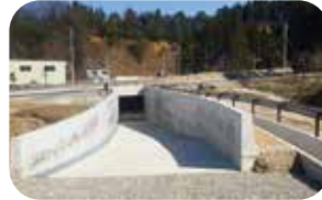
道路改良工事 (社会資本整備総合交付金)(函渠工)
