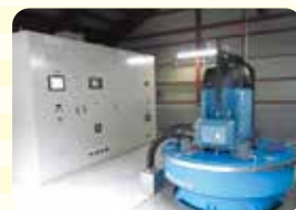
小水力発電工事
