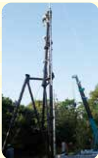
鉄塔組立作業 台棒とウインチで組立
