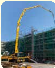
圧送工事風景
