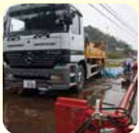
ドイツ製ポンプ車による圧送工事
