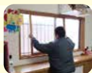
枠を取り付けたら、障子(ガラス)の建込み調整を行います。
