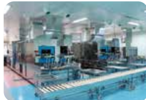
学校給食センター厨房
