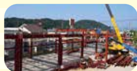
建方 現場に運んだ材料はクレーンを使って設置します。
