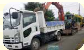
道路を掘削し、下水管を埋めるため準備をします。
