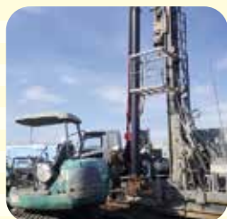
井戸工事(さく井)
