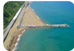
あわら北潟国有林突堤工事
