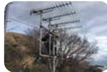
電気通信工事
