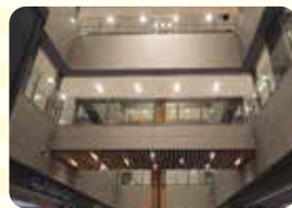
市庁舎ホール照明工事
