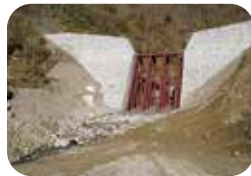
鋼製スリット堰堤工事
