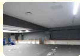
屋内照明工事
