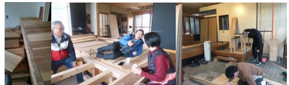
図 5-5 改修の様子。ステージのエッジのおさまり
