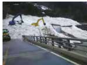
雪崩に巻き込まれた スノーシェッド
