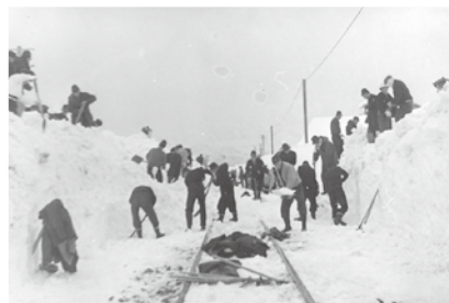
越前大野駅付近の線路を除雪する消防団員 (提供：市消防本部)
