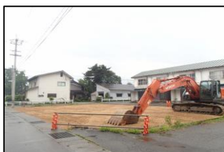
◆西里団地解体工事
