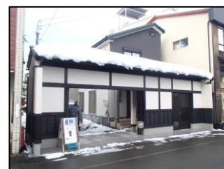
◆景観形成工事事業(五番通り)
