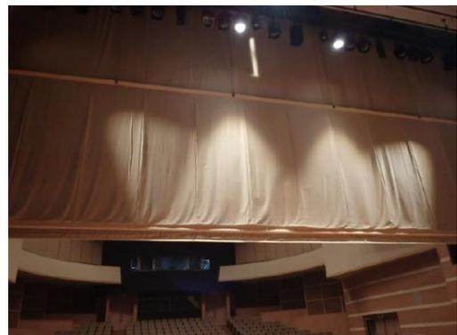
舞台上部緞帳(景観条例により施設に高さ制限があるため三つ折方式を採用)
