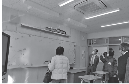
改修された普通教室
