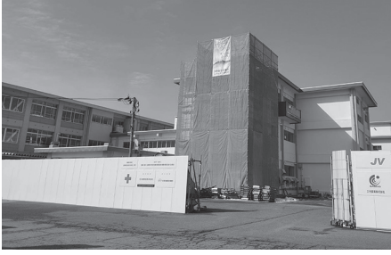
陽明中学校の改修
